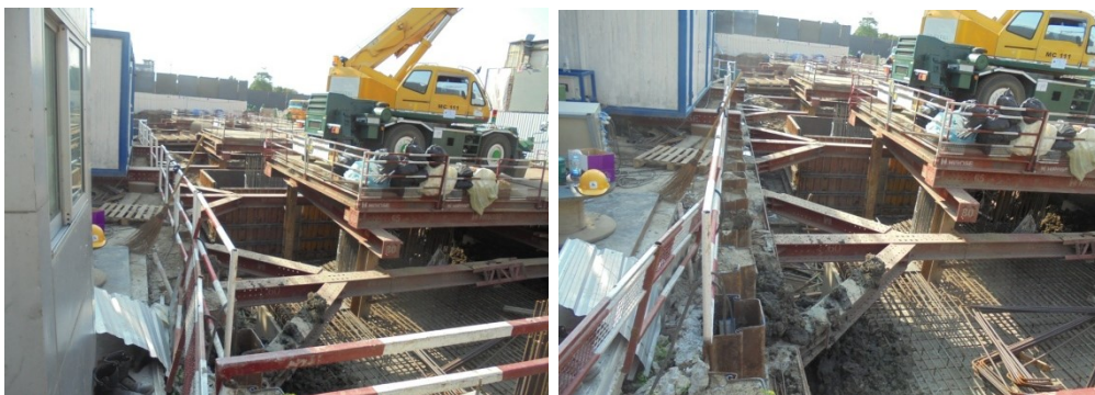
ภาพที่ 4-21 ทำระบบป้องกันดินพัง Sheet Pile
