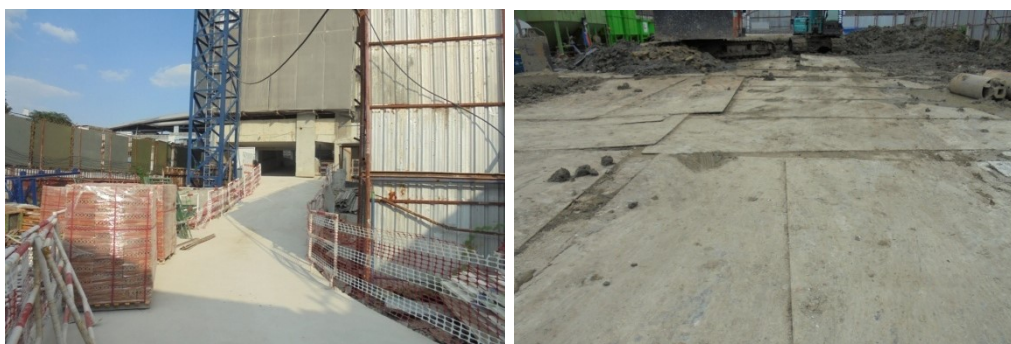
ภาพที่ 4-7 ปูแผ่นเหล็กหนาไว้เป็นทางวิ่งรถ และปัจจุบันเป็นพื้นคอนกรีตสำหรับให้รถวิ่ง
