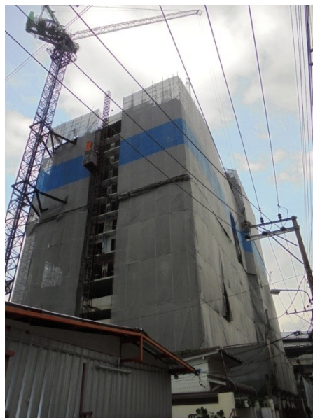
ภาพที่ 4-31 ติดตั้งทาวเวอร์เครนไว้บริเวณกลางพื้นที่โครงการ
