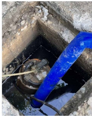
ภาพที่ 4-42 ขุดลอกตะกอนในท่อระบายน้ำและบ่อกักน้ำทิ้ง
